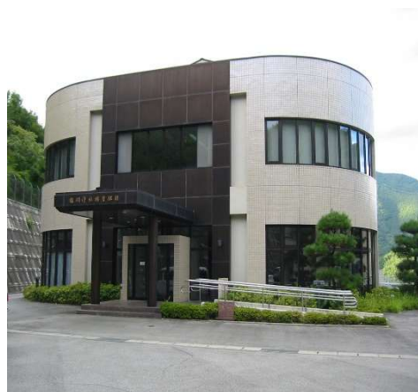
塩川浄水場 管理棟
